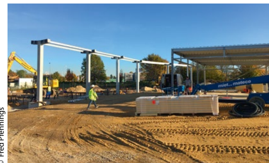
Bei Neubauten verzichtet Pfenning inzwischen auf Heizungen. Die Abwärme der Kühlgeräte reicht aus.
