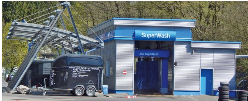
Die Skywing-SB-Anlage entstand 2011, in der Halle rotiert bereits die fünfte Christ-Anlage.
