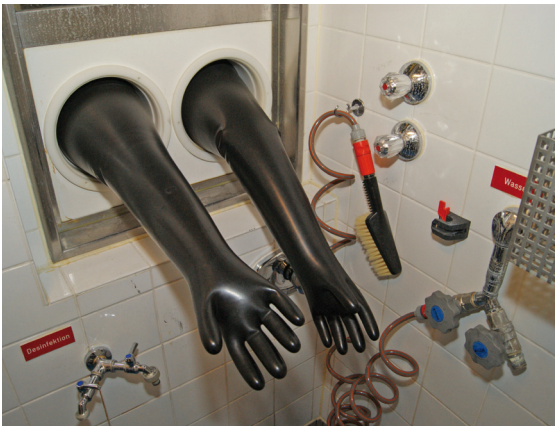
Die Dekontaminationsdusche arbeitet mit normalem Wasserleitungsdruck. Als Waschbürste dient eine gewöhnliche Autowaschbürste.
