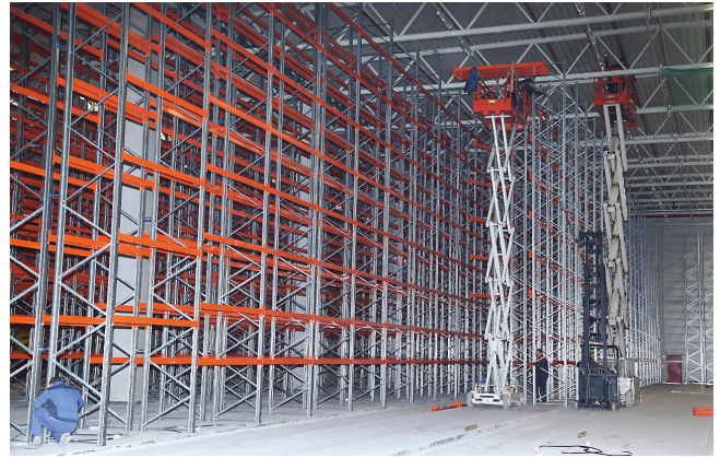
Die 12 Meter hohe und 73 Meter lange Regalanlage bietet 25.000 Palettenstellplätze.
