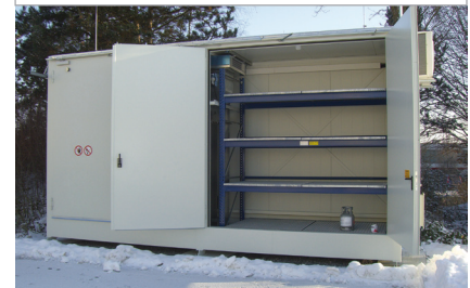
Beispiel für Lithiumbatterien: ein F90 Brandschutzlager, klimatisiert, mit säurebeständiger und elektrisch leitfähiger PE-Einlegwanne, im Inneren ausgelegt für Ex-Zone 1.
