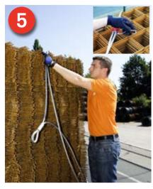
Fehlen Steckrungen, kann z. B. das DoUniFlex-System verwendet werden. Der Haken (kleines Bild) verhindert das Abrutschen des Seils.
